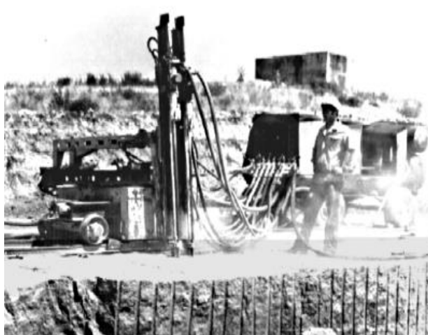
Бурение шпуров агрегатом СБА-2р на карьере (1986г.)
